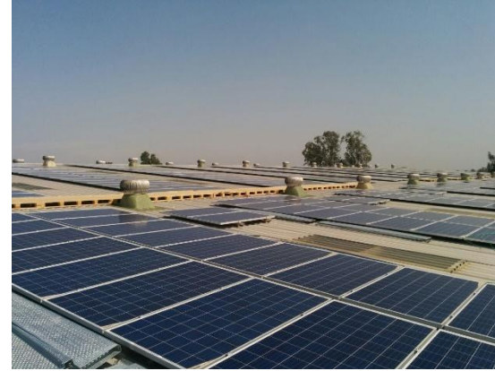
Metal Roof Installation (Kajaria Ceramics Gelpur, 1.3 MWp)
